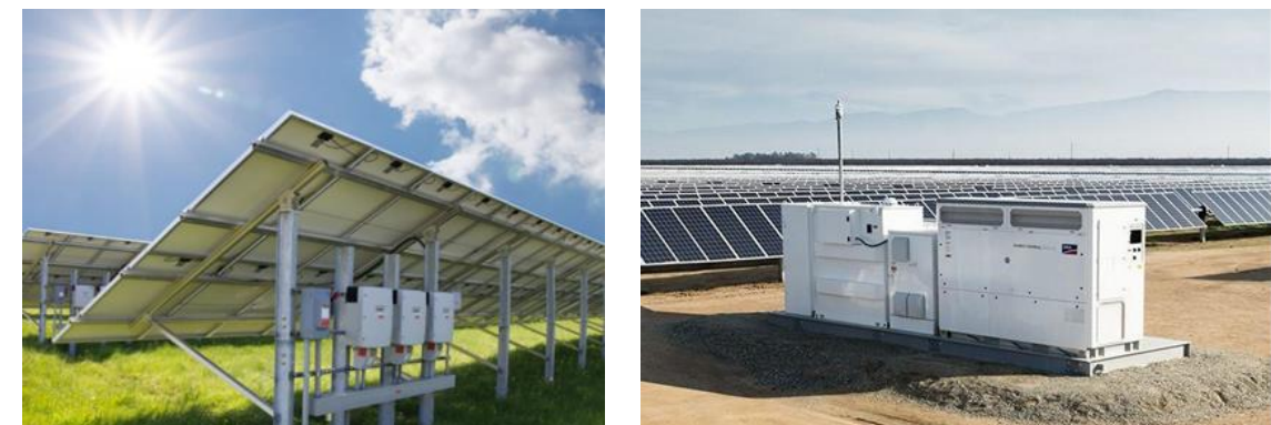
Figure 30 : Comparaison de différents onduleurs : strings ou centralisé
