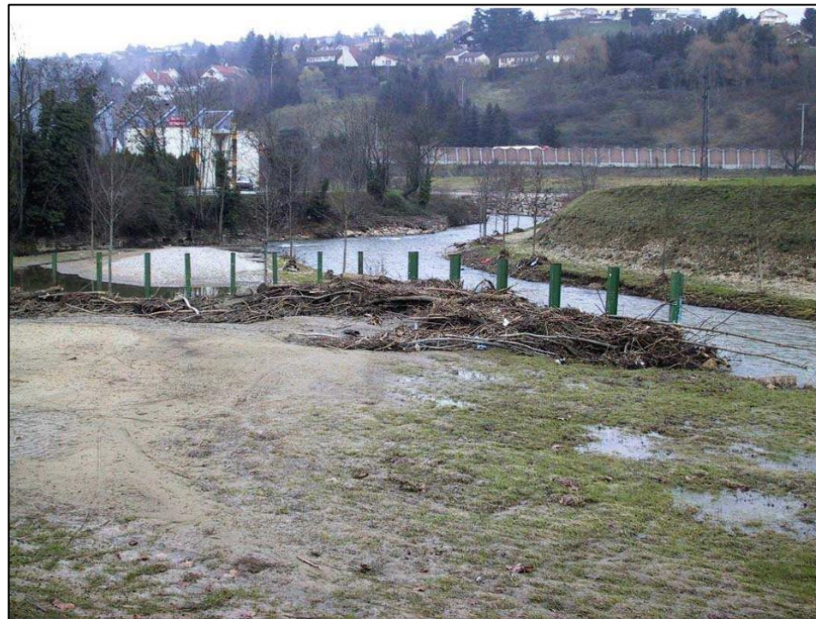
Figure 122 : Exemple de piège à embâcles artificiel (pieux métalliques)
