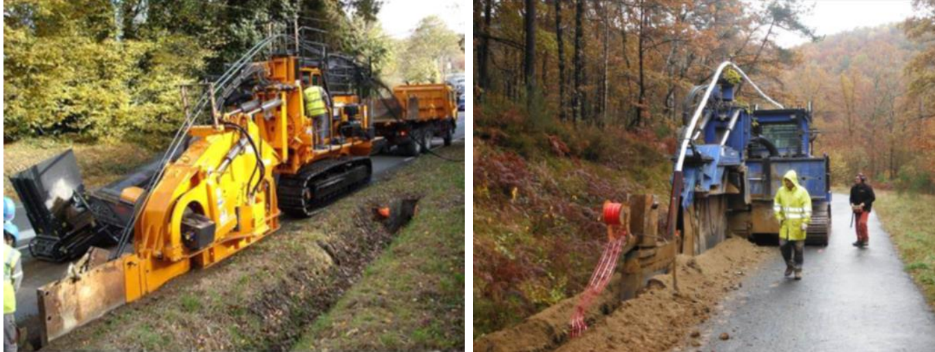
Figure 36 : exemples d'utilisation de trancheuse pour la pose de câbles enterrés
